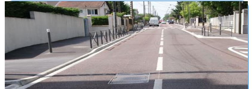
Voirie, éclairage public, espaces verts, etc.
