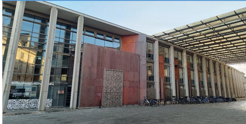
Modernisation des bâtiments municipaux
