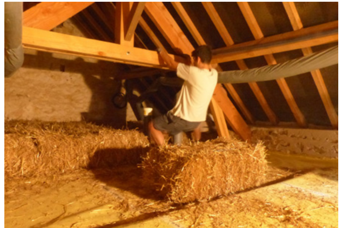
Exemple d'isolation en botte de paille (Source : PNR Brenne)
