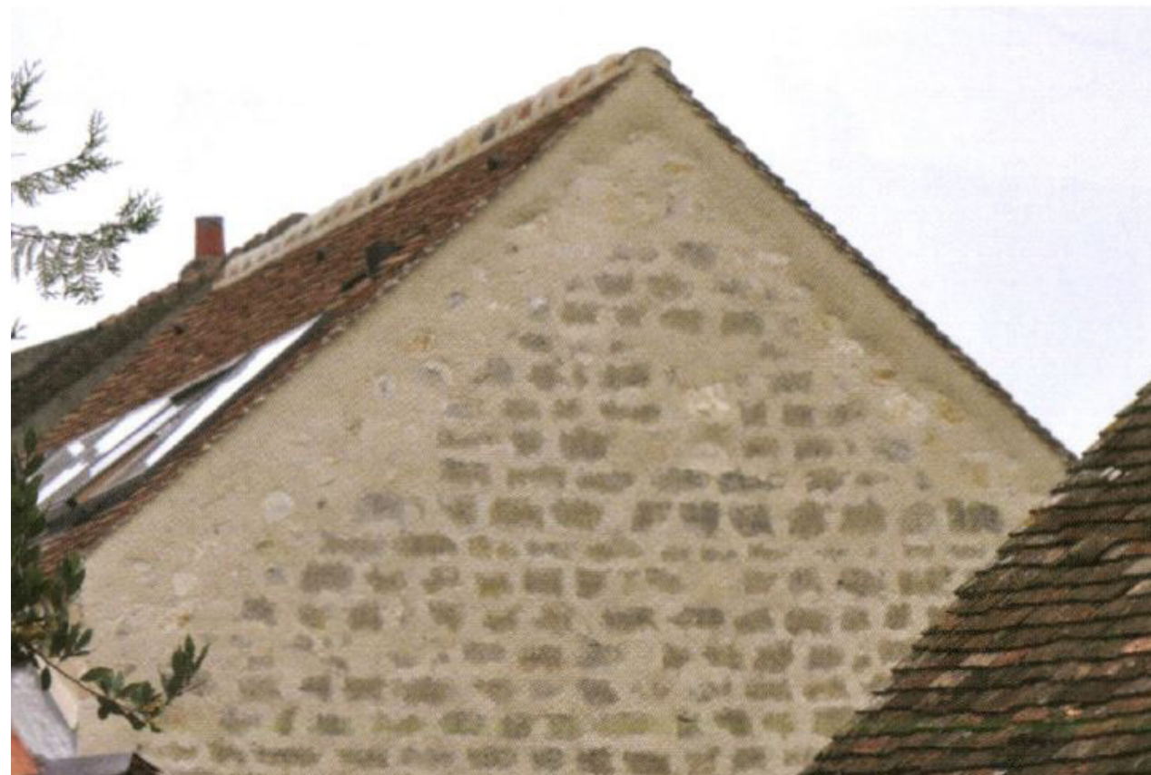
Aspect des rives après travaux, enduit à la chaux (Source : MPF)
