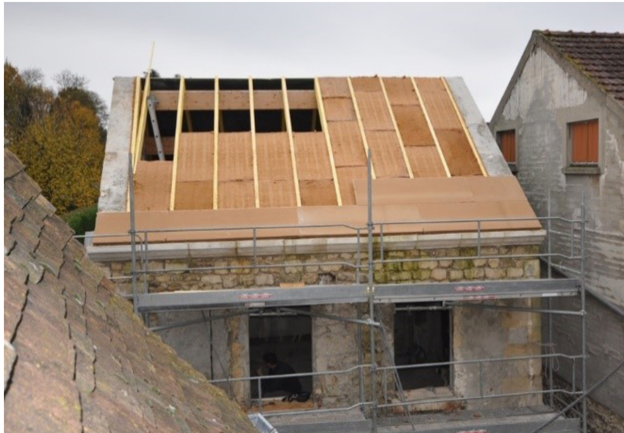
ISOLATION DE LA TOITURE EN FIBRE DE BOIS D'UNE MAISON DE VILLE
